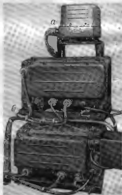
Фиг. 227. Установка радиостанции и усилителя СПУ.
